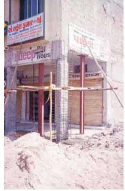
चित्र-1 पुरानी आर.सी.सी. बीम एवं कॉलमों को जोड़े बिना ही सजावटी कालम जैकेटिंग को अपनाया गया।
