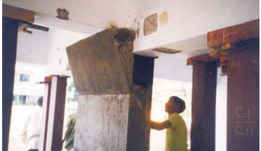
चित्र-4 कंक्रीट (खंभे) के कॉलम शीर्ष पर कीपनुमा फ्रेम वर्क
