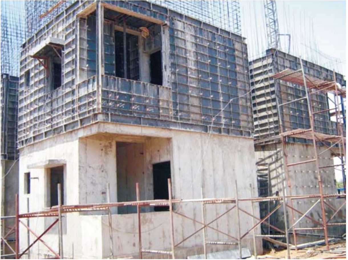
उभरती प्रौद्योगिकी-प्लास्टिक-अल्युमिनियम मिश्रित ढांचा के इस्तेमाल से अखंड कंक्रीट निर्माण प्रणाली
