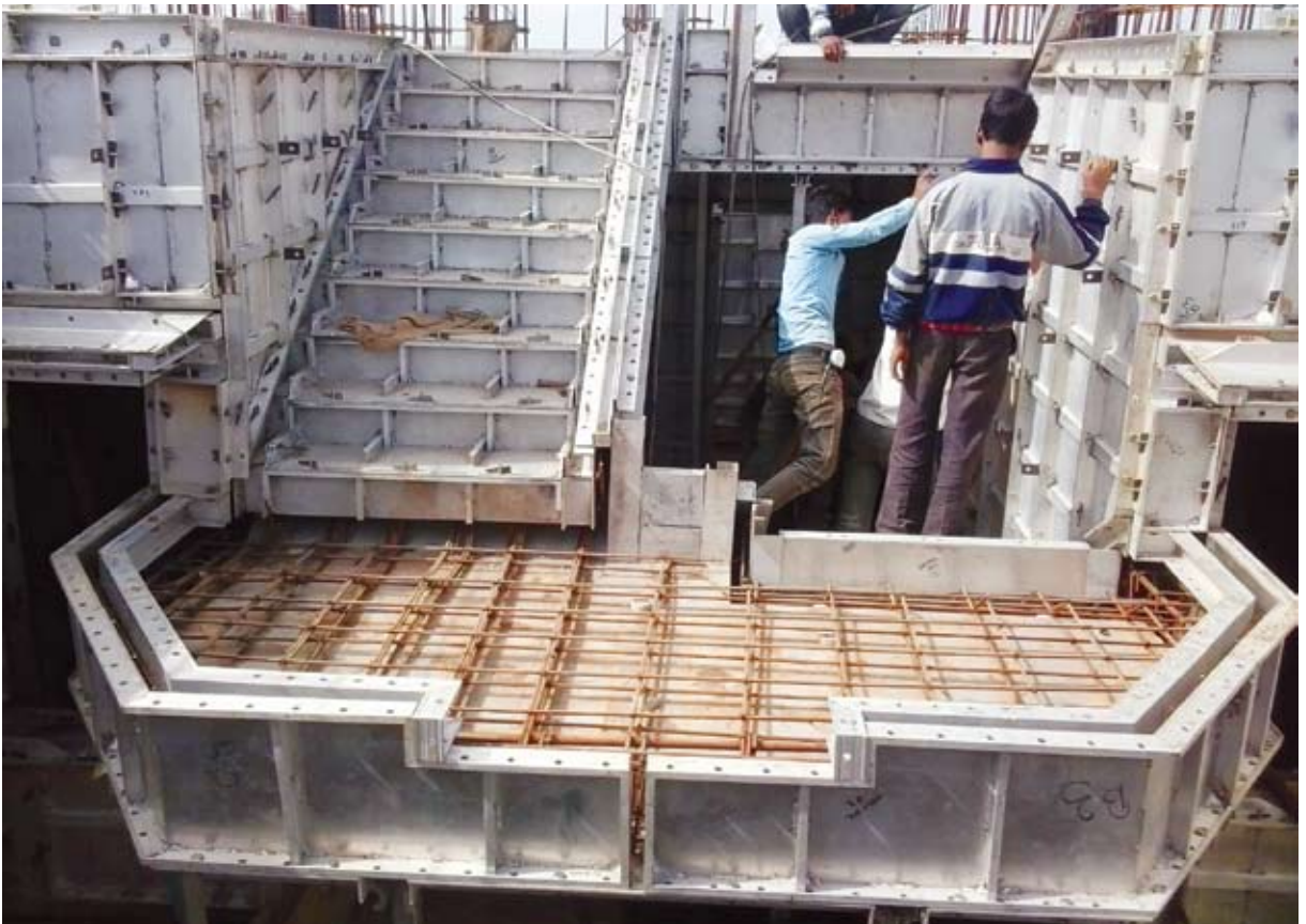
उभरती प्रौद्योगिकी-अल्युमिनियम ढांचा के इस्तेमाल से अखंड कंक्रीट निर्माण प्रणाली ।
