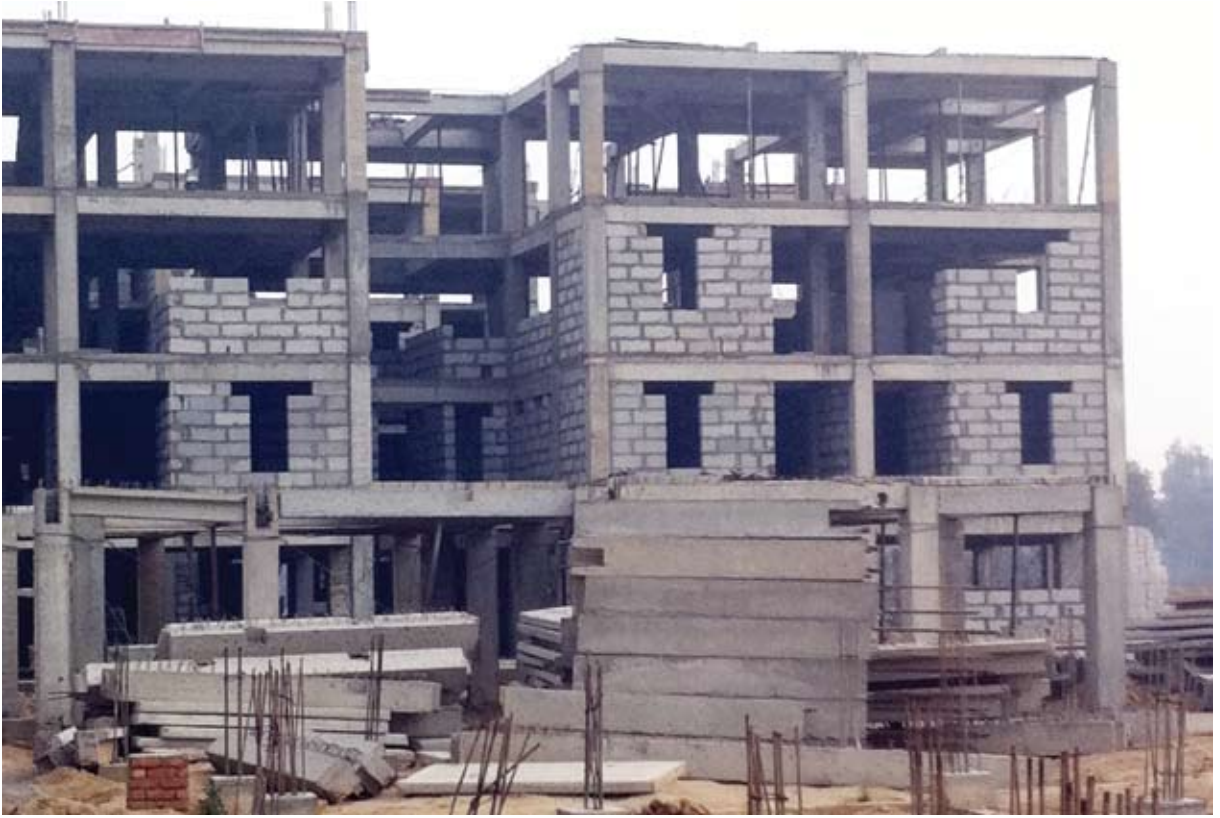
उभरती प्रौद्योगिकी-सेल्यूलर हल्के भार के कंक्रीट के टुकड़ों एवं पूर्व निर्मित टुकड़े के इस्तेमाल से औद्योगिकृत 3-एस प्रणाली ।
