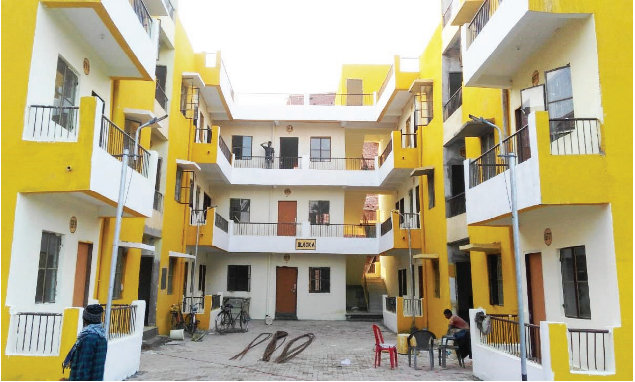
बिहारशरीफ, बिहार में कॉफर संरचनात्मक स्टे इन प्लेस फॉर्मवर्क प्रणाली का इस्तेमाल करते हुए निर्मित प्रदर्शन आवास (36 आवास इकाईयां)
