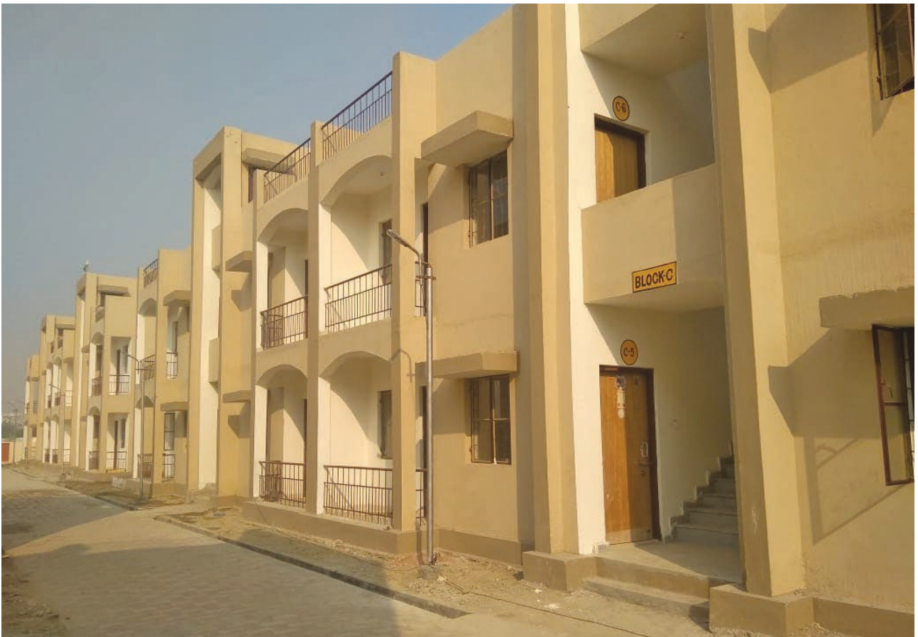
लखनऊ ,उत्तर प्रदेश में स्टे इन प्लेस ईपीएस आधारित दोहरी दीवारयुक्त पैनल प्रणाली का इस्तेमाल करते हुए निर्मित प्रदर्शन आवास (40 आवास इकाईयां)
