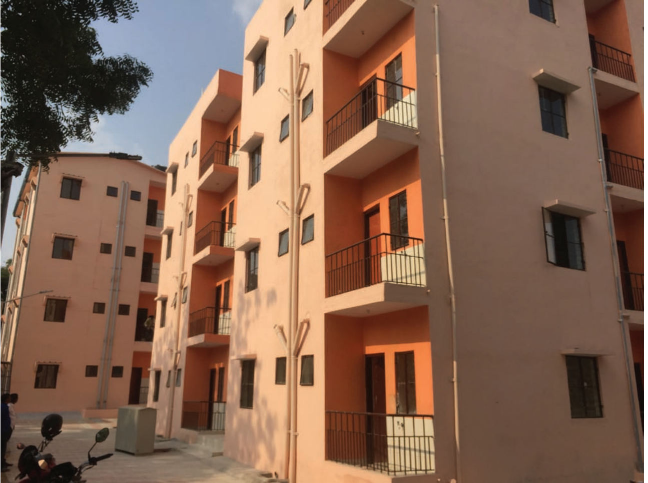
गांचीबावली, हैदराबाद, तेलंगाना में कॉफर संरचनात्मक स्टे इन प्लेस फॉर्मवर्क प्रणाली (16 आवास) एवं हल्की वजनी गेज स्टील फ्रेमयुक्त प्रणाली (16 आवास) का इस्तेमाल करते हुए निर्मित प्रदर्शन आवास
