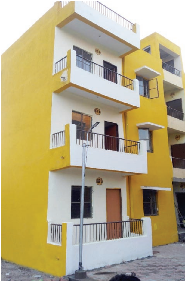
बिहारशरीफ, बिहार में कॉफर संरचनात्मक स्टे इन प्लेस फॉर्मवर्क प्रणाली का इस्तेमाल करते हुए निर्मित प्रदर्शन आवास (36 आवास इकाईयां)
