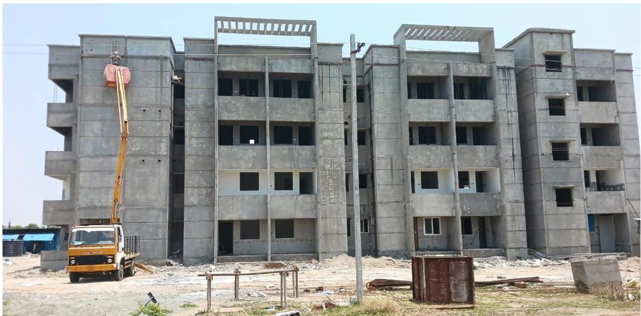
**तिळपुर, तमिलनाडु में प्रीकास्ट कंक्रीट निर्माण प्रणाली-साइट पर असेंबल किए गए प्री कास्ट घटक का उपयोग करते हुए प्रदर्शन आवास परियोजना का निर्माण कार्य प्रगति पर**
